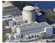
関西電力美浜原発3号機＝福井県美浜町
