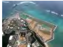
普天間飛行場の移設へ向けて、埋め立て
