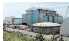
青森県大間町に建設中の大間原発＝7月
