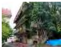
老朽化して誰も住まなくなったマンション。
