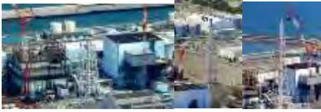
東京電力福島第一原発1、2号機の共用排気筒（高さ120メートル、直径約3メートル）の上半分の撤去作業が29日、終わった。事故当時、放射性物質を含む水蒸気を放出する「ベント（排気）」に使われた施設だが、倒壊する恐れがあった。
