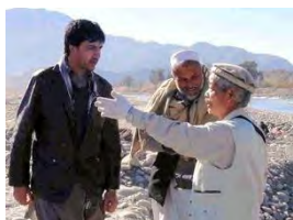
アフガニスタンでの工事で指揮を執る
