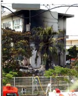
米軍ヘリが墜落した現場と壁が黒く焼け焦げた大学の建物＝04年8月13日、宜野湾市宜野湾の沖縄国際大学
