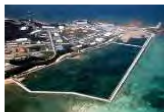
埋め立て工事が進む辺野古沖=2
