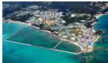
移設工事が進められている
