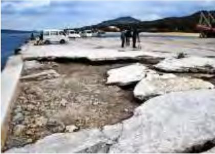
台風の影響でコンクリート舗装が剥がれ、一部路盤がむき出しになっている本部港塩川地区＝2日午前
